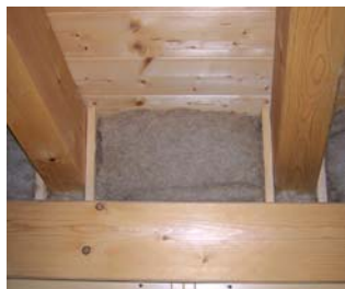
Tamponamento fra i travi
