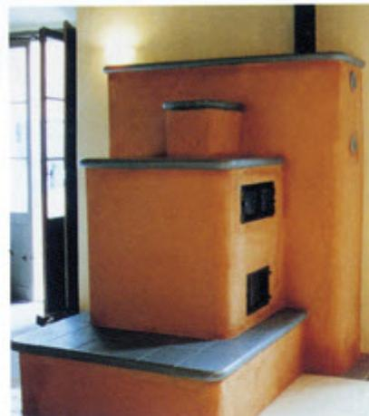
Fasi della costruzione di una stufa in terra cruda con anima in materiale refrattario e rivestimento in mattoni ed intonaci di terra cruda.
